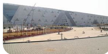
建設中の大エジプト博物館 (GEM)。こちらには、ラムセス2世の立像、そしてツタンカーメン王の副葬品などが一同に展示されるそうだ。
