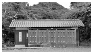
▼岩屋寺駐車場の多目的トイレ
