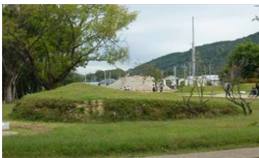
円墳が崩れかけている
