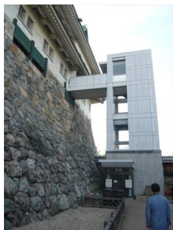
閉鎖されたエレベーター
