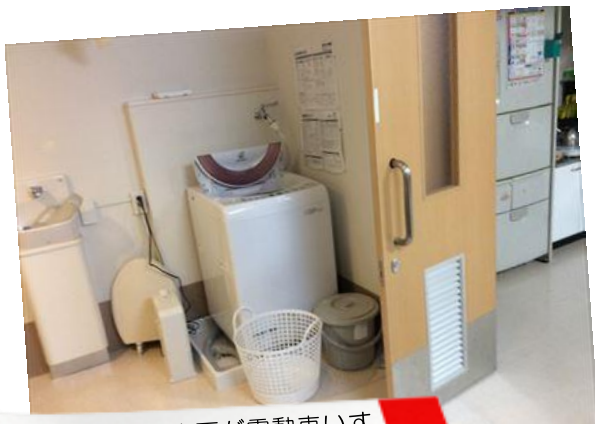
脱衣場の内開き扉が電動車いすにあたるので改修したい
