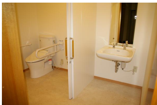
2つのトイレ（和式と洋式）を車いす対応トイレに改修 右側の洗面台は車いすのまま使える仕様
