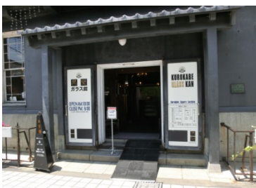
黒壁1号館 入口にスロープ設置
