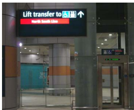
シンガポール地下鉄のエレベーター。新しい設備で使いやすくなっています。
