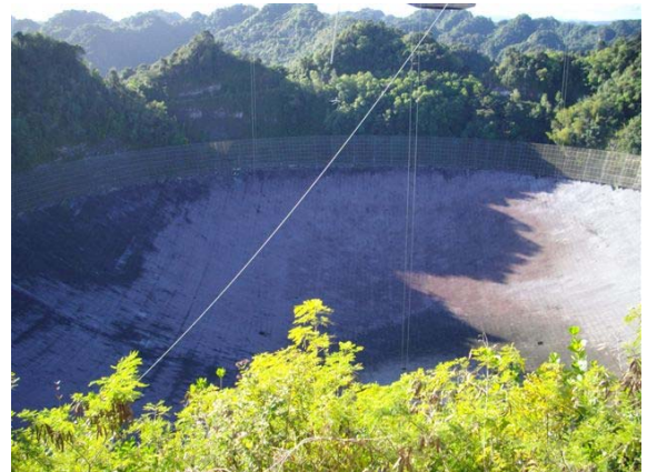
アレシボ天文台 世界最大直径305メートルの電波望遠鏡。
