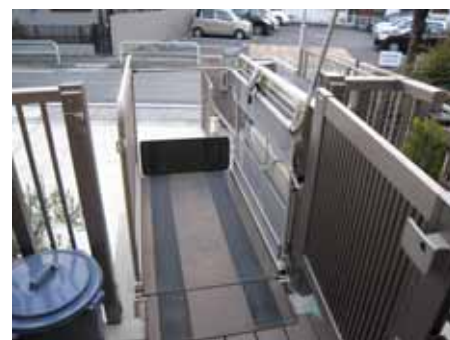
デッキから段差解消機への乗り降り
