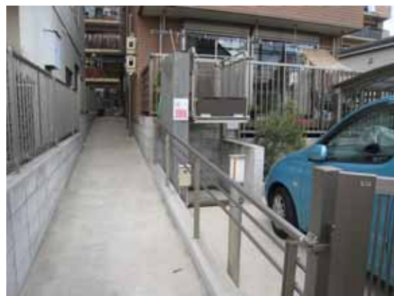
屋外スロープ
