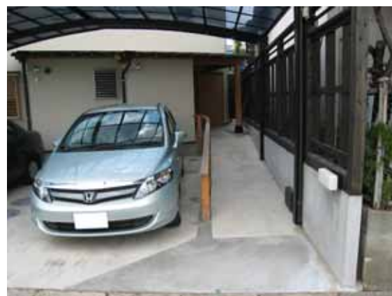
駐車場と玄関スロープ
