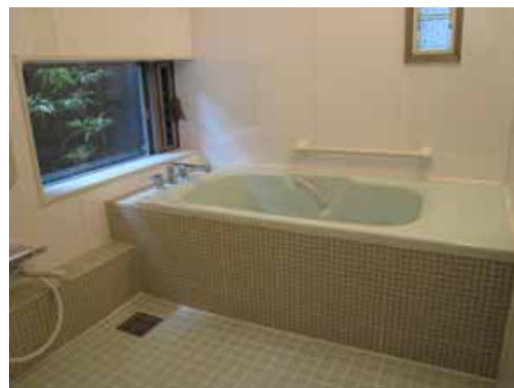
浴室（浴槽右側に移乗用スペース）
